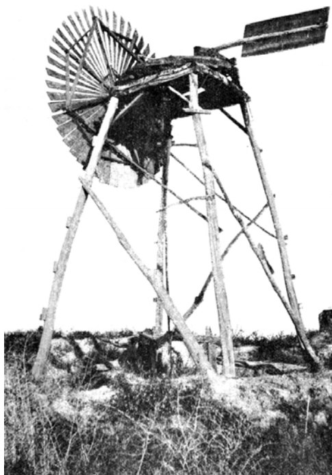
Сурет 1. Жел шығыр (желмен жұмыс істейтін суландыру қондырғысы), Перовск уезі, 1910 жыл, қазан [4].
